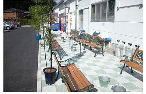
TBソーテック九州材株式会社 社休憩場での施工
